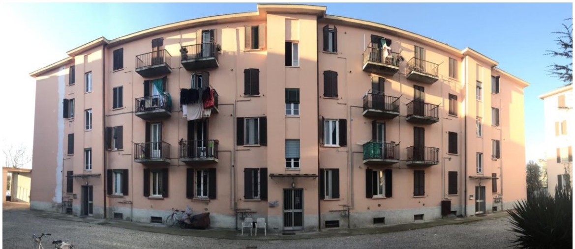
Figura n. 1.6 – report fotografico – stato di fatto
